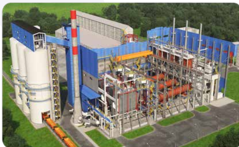
Фрагмент BIM-модели цеха сушки горно-обогатительного комбината, разработанной с применением технологий Model Studio CS и CADLib
